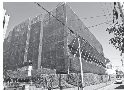
閑静な住宅街に立つ芦屋三条シティハウス
