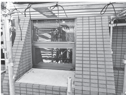
斜壁タイル面はウレタン防水への仕様変更により防水性能を高める計画だ
