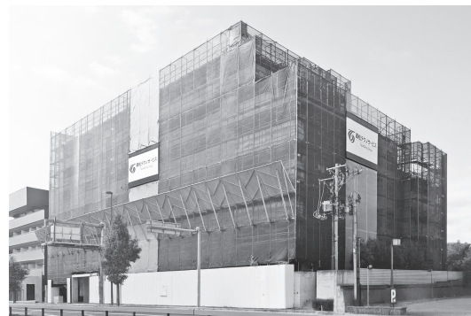
メッシュシートに緑色の縦ラインでアクセントを施し、足場の美観にこだわった
